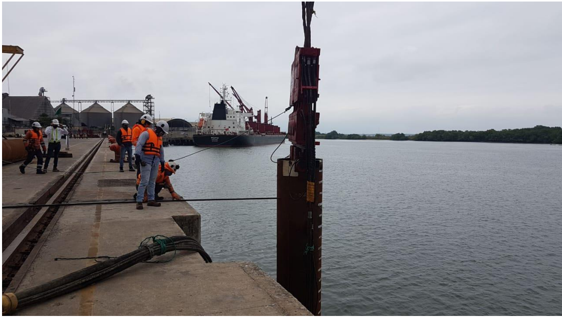
Figura 7.- Martillo ICE 44B – Vista Lateral
