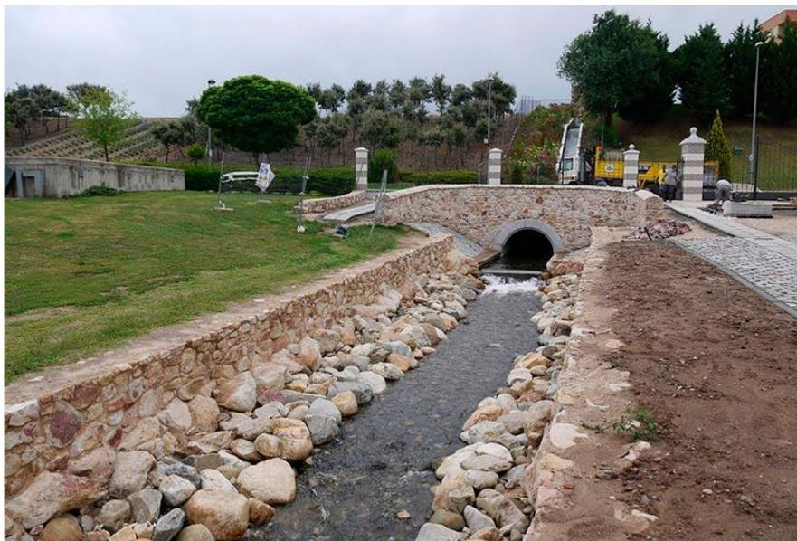
**Ilustración 7 Canal revestido con enrocado**
