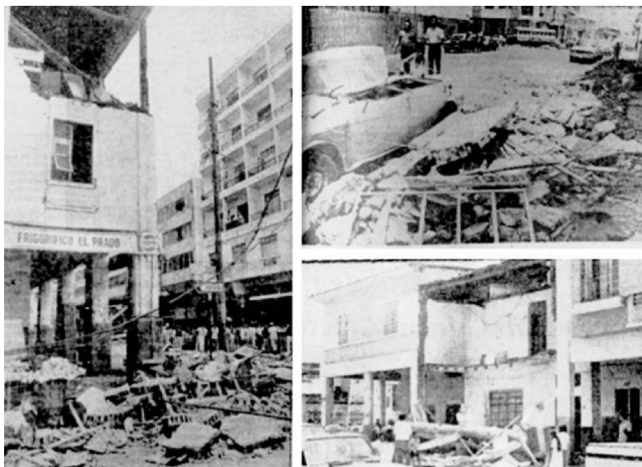
Ilustración 4. Edificaciones afectadas durante el terremoto del 18 de Agosto del 1980.
