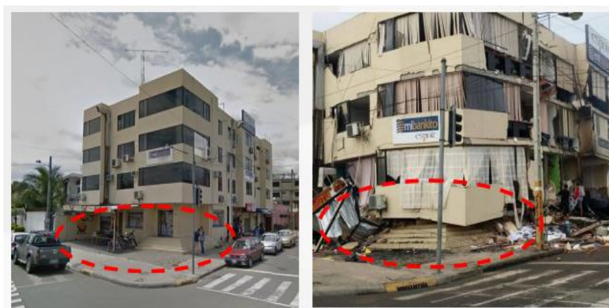
Ilustración 15. Antes y después de edificio esquinero con piso flexible ubicado en el centro de Portoviejo
