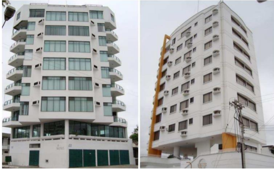
Ilustración 8. Evidencia de pisos blandos en las construcciones. Izquierda Edificio Nautilus.
