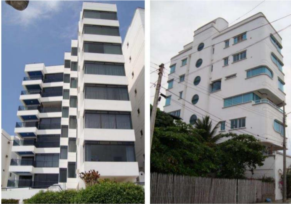
Ilustración 9. Irregularidades arquitectónicas. Izquierda: Edificio El Almirante (irregularidad en planta). Derecha: Edificio S/N (irregularidad en elevación)
