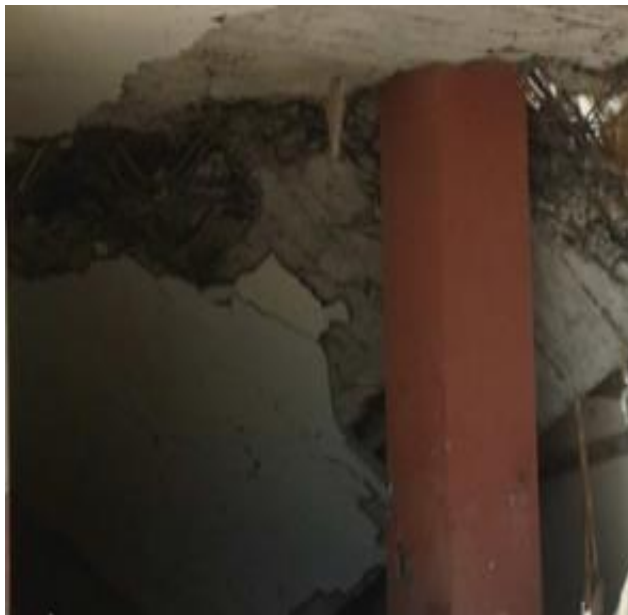
Ilustración 17. Efecto de punzonamiento
