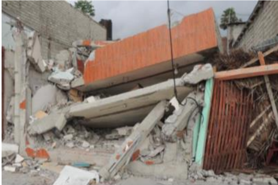
Ilustración 16. Losa plana en edificación de dos plantas
