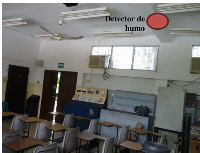
Figura 3.16 Ubicación recomendada del detector fotoeléctrico de humo modelo 5806W3 de la marca Honeywell Elaborado por: Autor
