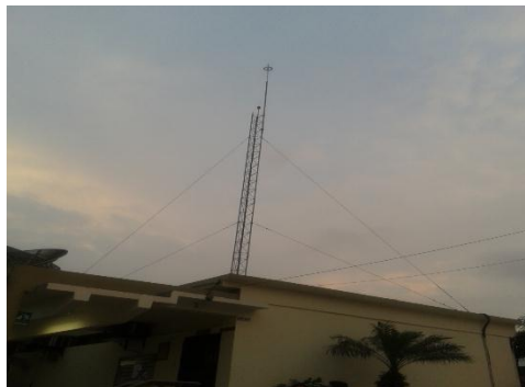
Fig. 3.16: Torre de 9mts de altura ubicada en la parte superior del laboratorio de computación Fuente: Autor
