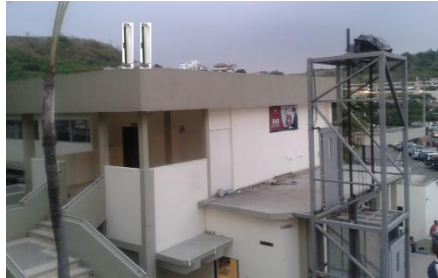
Fig. 4.4: Simulación de instalación de equipos de radio (Facultad de Agronomía)
