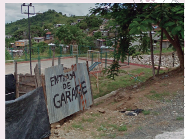
2. Cancha con parque en mal estado.
