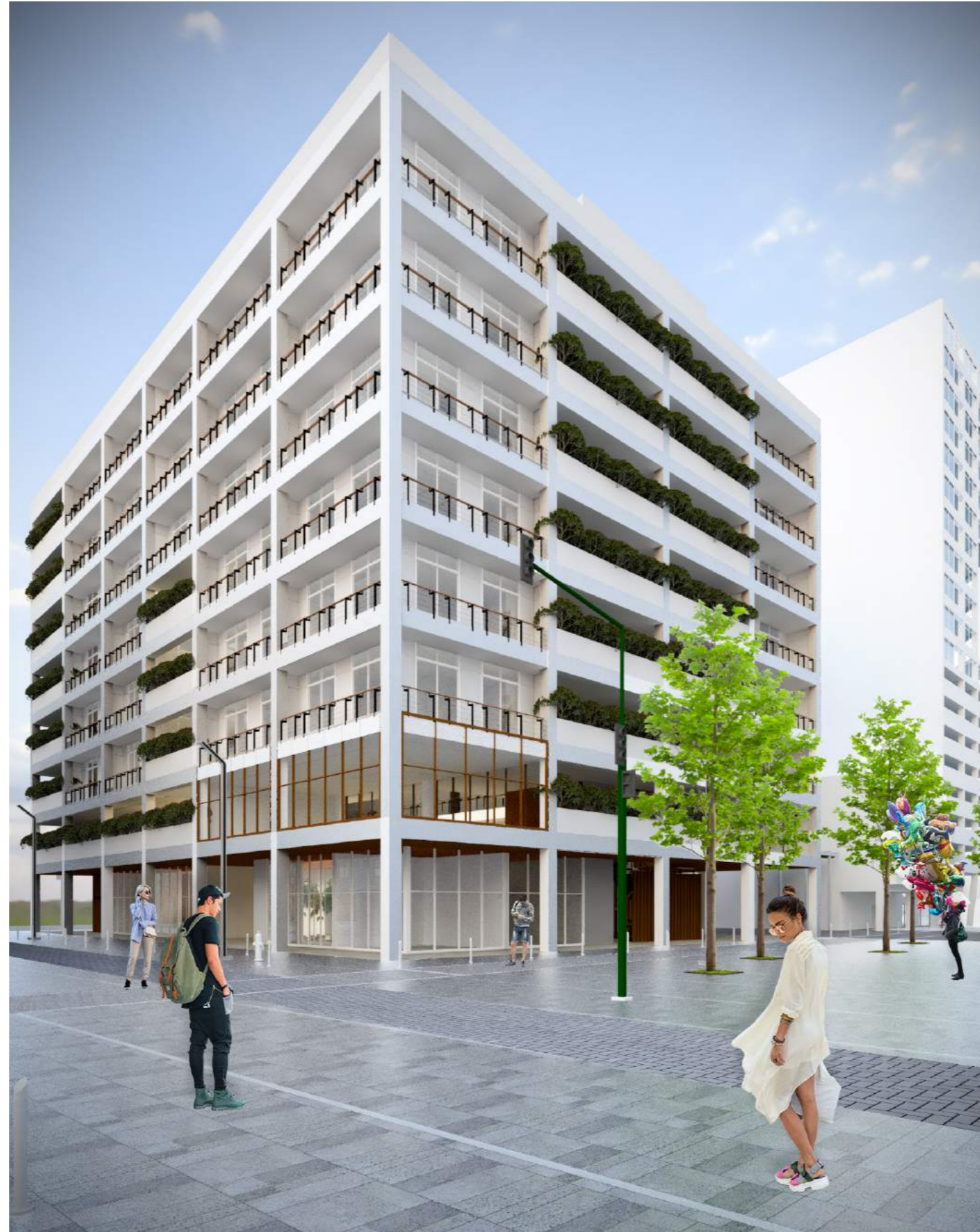
Vista del edificio desde la intersección entre la Calle Panamá y la Calle Tomás Martínez
