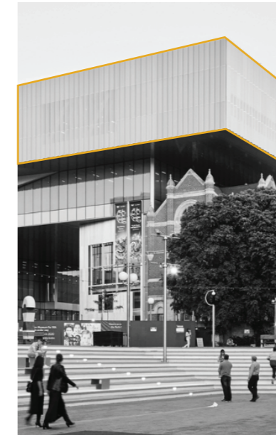
Fachada cerrada Piel de plancha perforada
