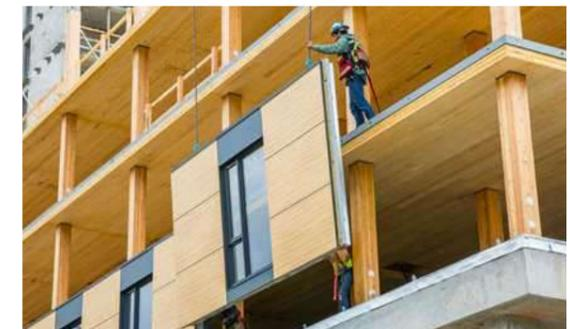
La instalación de cada panel se la puede realizar en sitio o se la puede instalar en forma de módulo prefabricado por medio de grúas.
