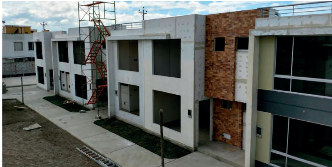
Ilustración, Uso de paneles MgO, prometal.ec
