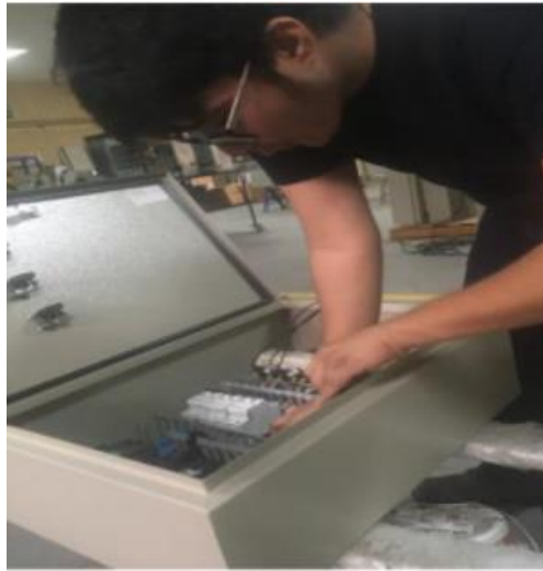
Figura 3.12. Ensamblaje del tablero. Fuente: Elaborado por el autor.
