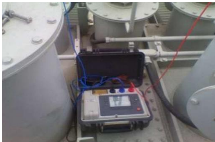
Conexión del equipo de medición en banco de transformadores
