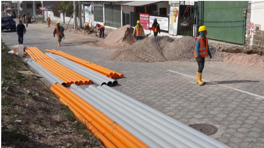
Figura 2.4: Ductería en proyecto de "Construcción de Infraestructura Subterránea para las Redes de Conectividad y Energía Eléctrica" en Quito
