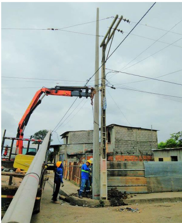
Figura 2.8: Colocación de poste de concreto por personal de CNEL EP. Fuente: (Mieles, 2019a)
