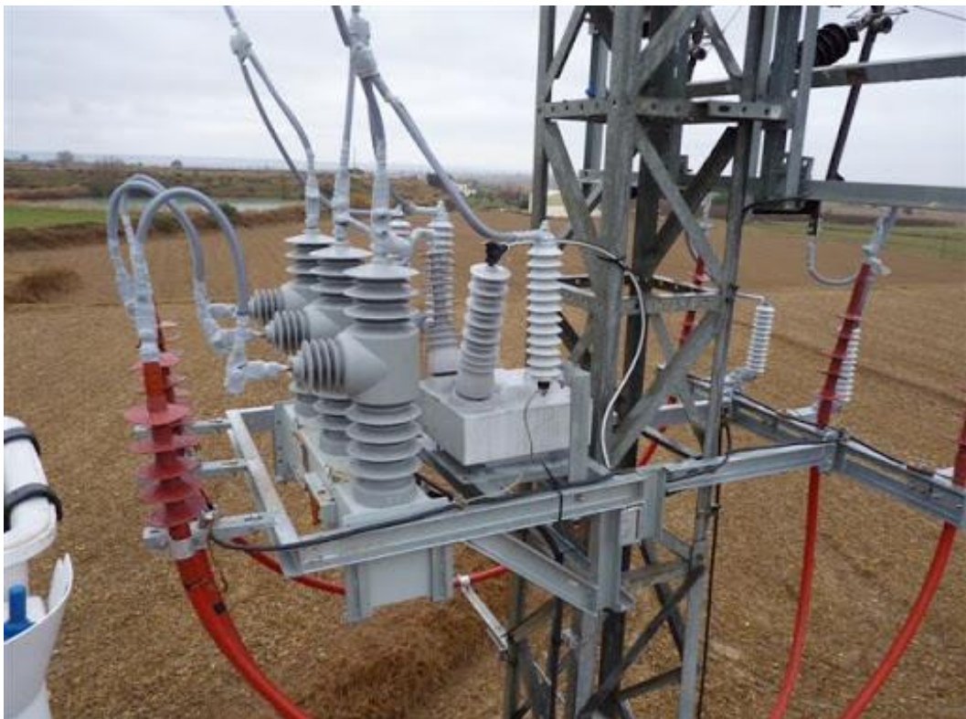
Figura 2.12: Equipos de seccionamiento Fuente: (Mastrafo, 2020)
