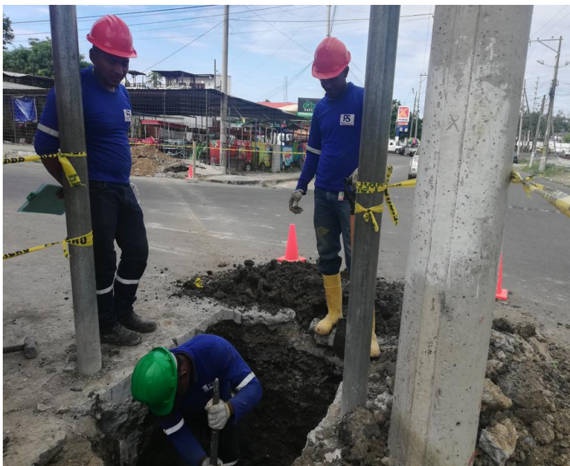
Figura 2.3: Elaboración de cajas de paso para redes subterráneas Fuente: (Mieles, 2019b)
