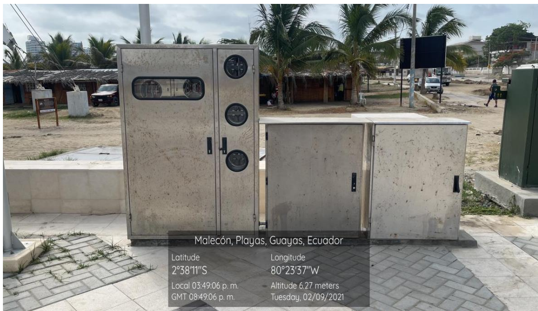
Figura 4.15: Tipo de panel de medidores para Plazoleta de mariscos Fuente: El autor
