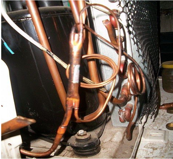
Figura 10. Ilustración del tubo capilar
