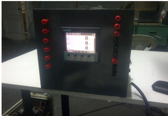
Figuras # 5.3: Montaje de equipos eléctricos
