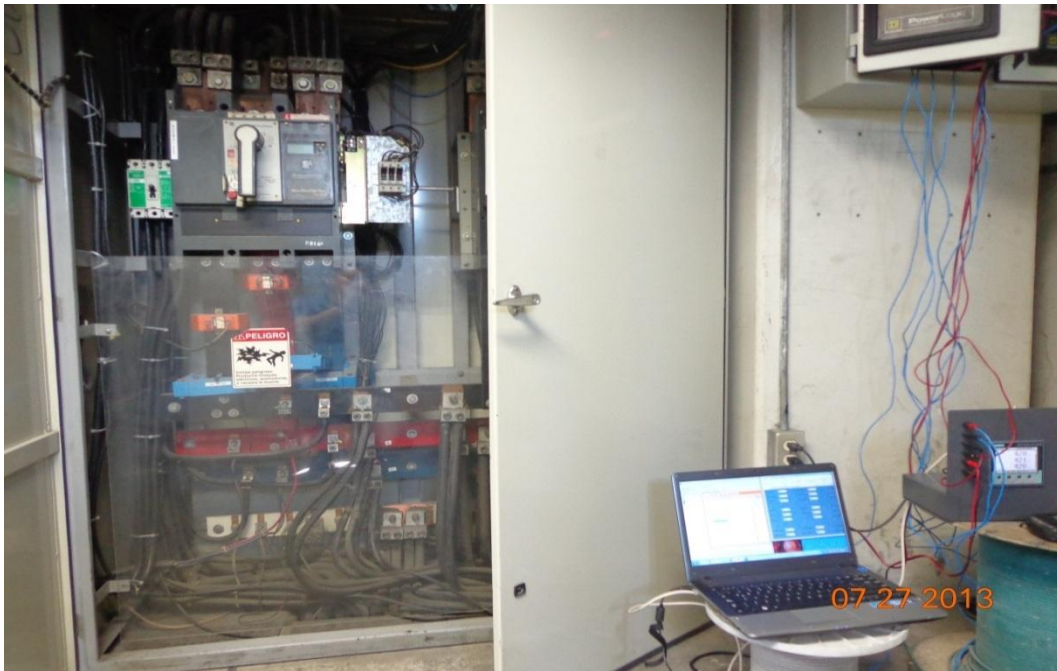
Figura 56: Realizando conexión en Gráficos Nacionales S.A
