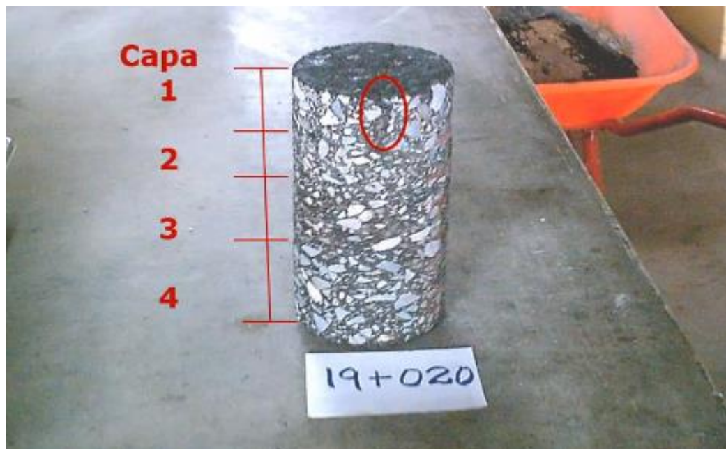
Figura 2.10. Núcleo extraído con grieta del tipo Top-Down. Tomado de materiales de clases de la asignatura Pavimentos. Ing. Rolando Vila. UCSG. 2019.
