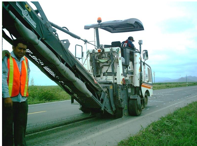
Figura 3.2. Trabajos de fresado en sectores de una vía
