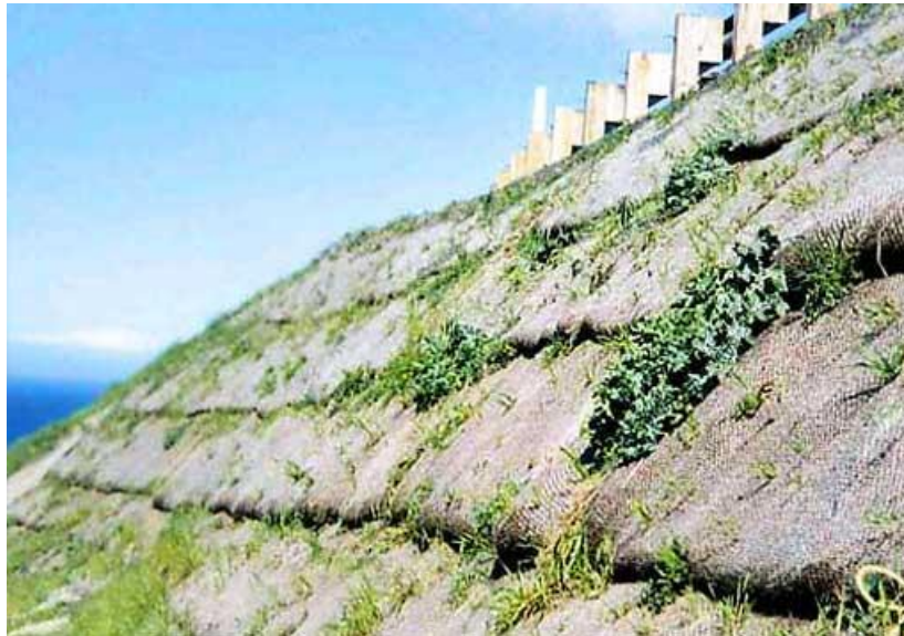
Figura 31. Protección de taludes con capa vegetal.
