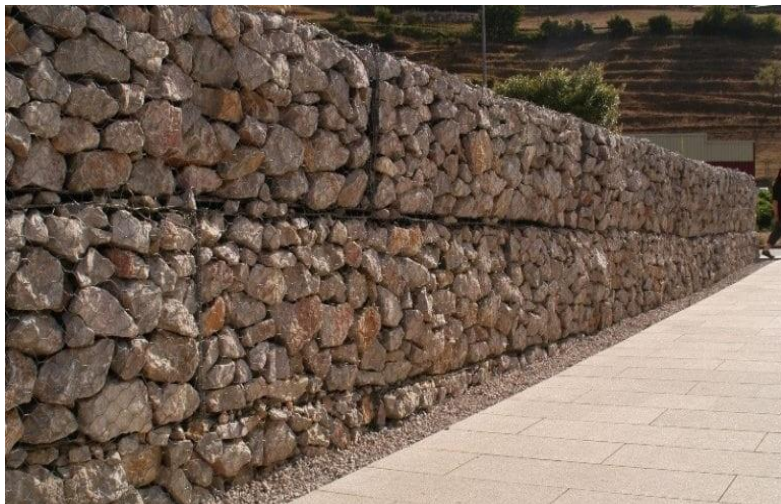
Figura 29. Gaviones como muro de contención.
