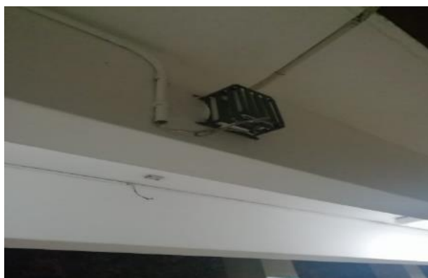
Figura 3. 10: Pilar horizontal de aulas con equipo Fuente: El autor
