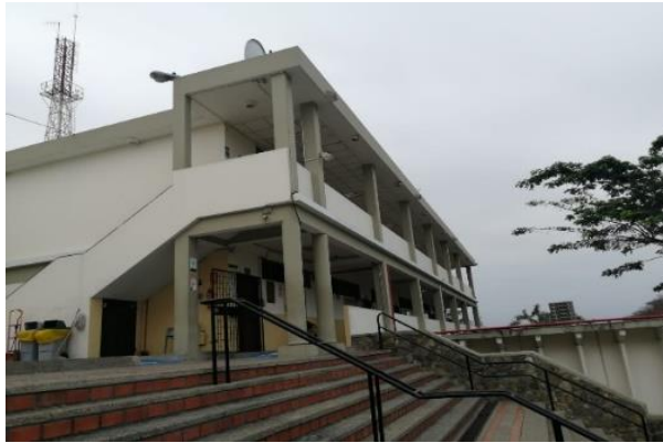
Figura 3. 3: Vista de antenas, torres mástil y Access Point externos Fuente: El autor
