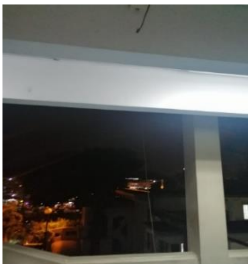
Figura 3. 7: Cable que cuelga afuera de los pasillos de aulas Fuente: El autor
