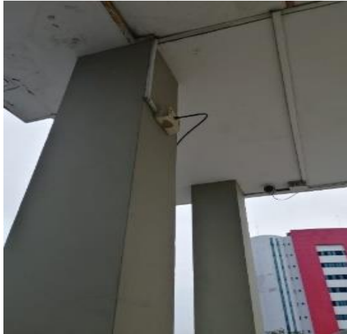
Figura 3. 8: Conexión de punto red que alimentaba la Access Point externa Fuente: El autor
