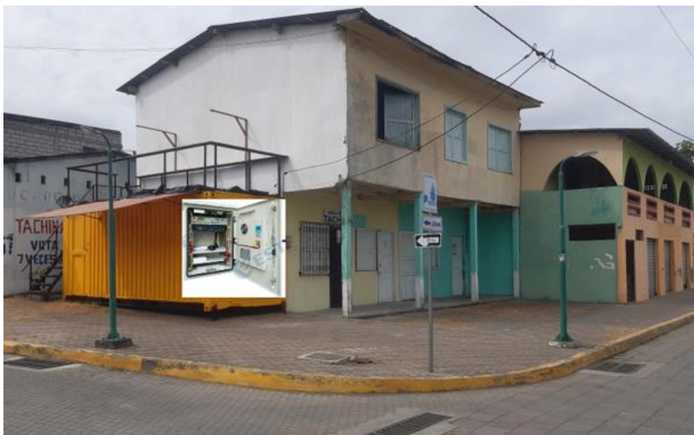
Figura 3. 14: Punto de ubicación del cuarto de equipos de la red. Elaborado por: Autor.
