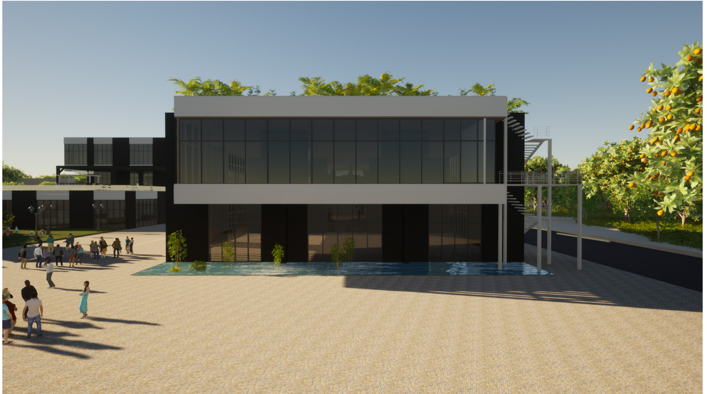
Fachada posterior del proyecto.
