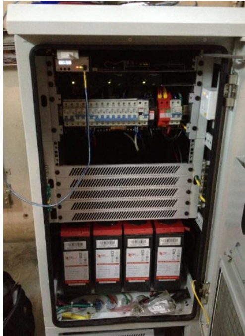
Figura 2. 5: Sistema de Rectificación en CNT. Elaborado por: Autor
