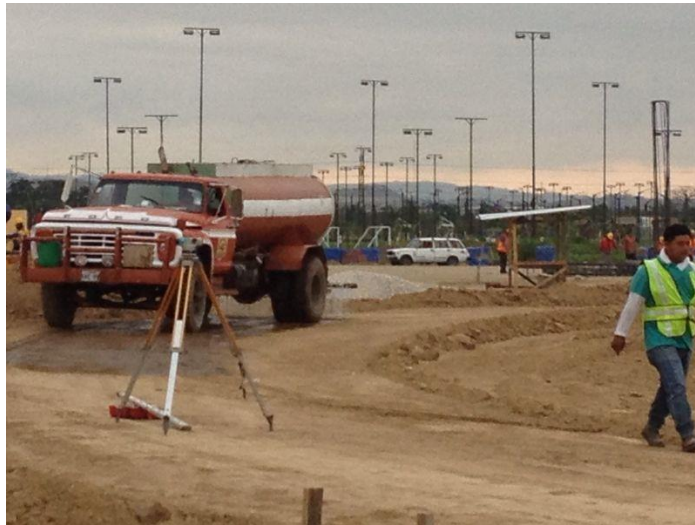
Imagen 33 Hidratación del terreno
