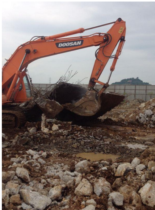
Imagen 24 Limpieza del terreno
