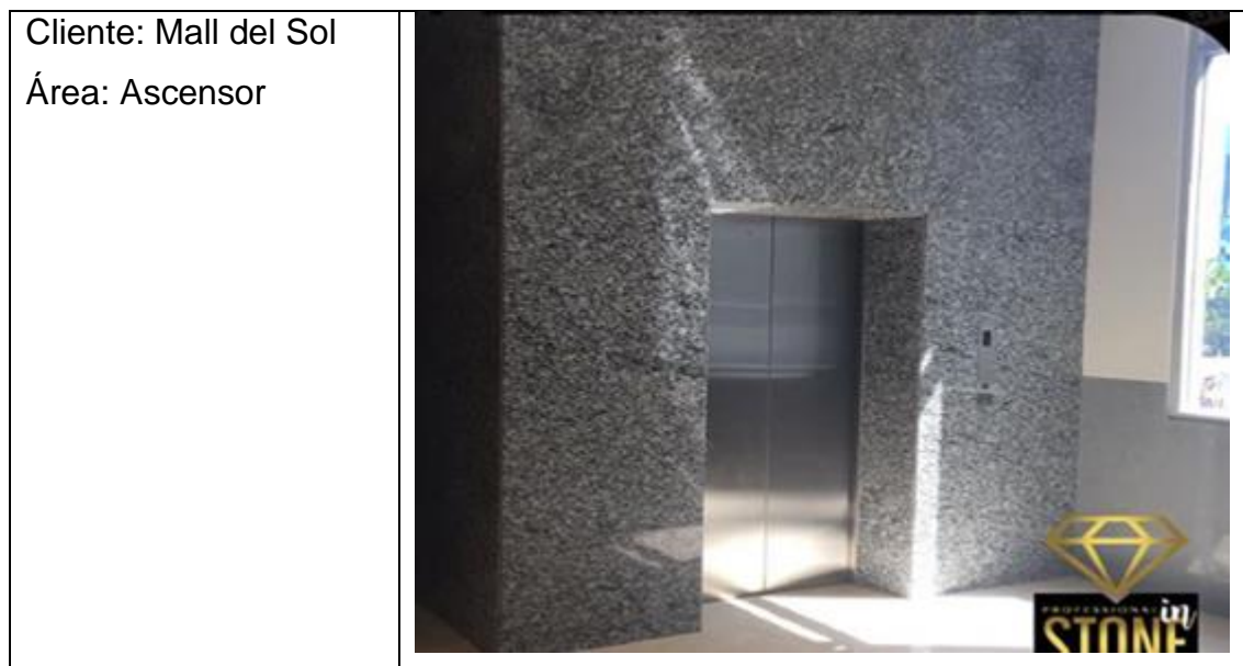
Figura 7. Instalación Granito en ascensor
