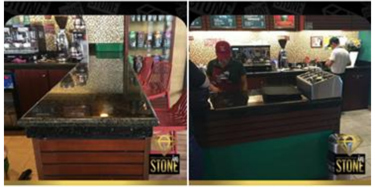
Figura 11. Remodelación e instalación
