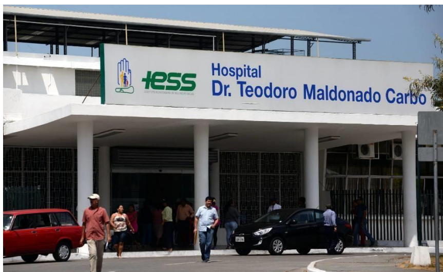
Figura 2. Entrada a las instalaciones del HTMC Tomado del HTMC en el año 2020.
