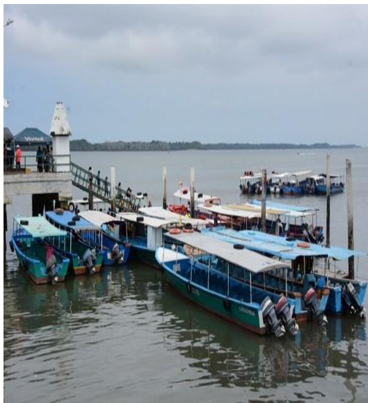
Figura 8. Muelle de Cabotaje.
