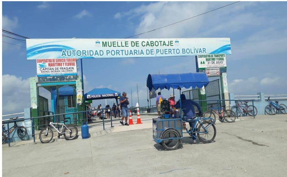
Figura 11. Muelle de cabotaje
