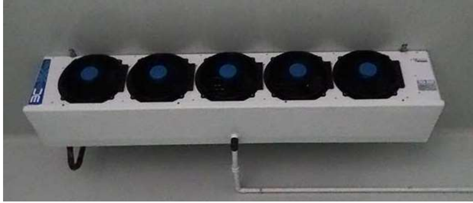
Figura 2.3: Evaporador Frigorífico de tres ventiladores. Nota: Obtenido de (Bernad Refrigeración, 2019)
