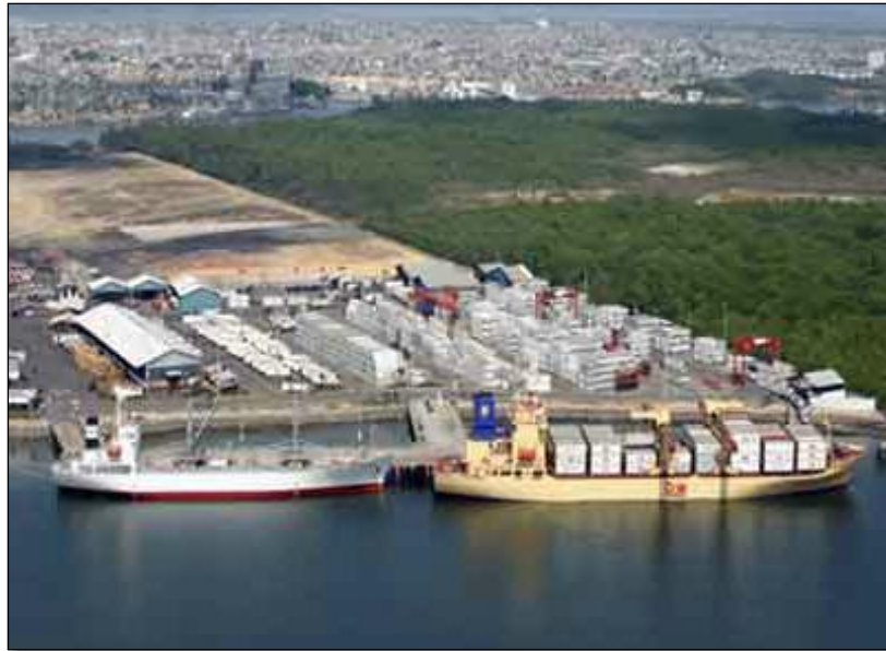
Figura 32 Muelle Privado Bananapuerto Fuente: Asociación de Terminales Portuarios Privados del Ecuador Elaborado por: Autora
