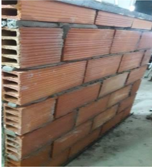
Ilustración 13: panel mampostería sin enlucir, lab. Estructuras UCSG, Edward Badillo, 2020
