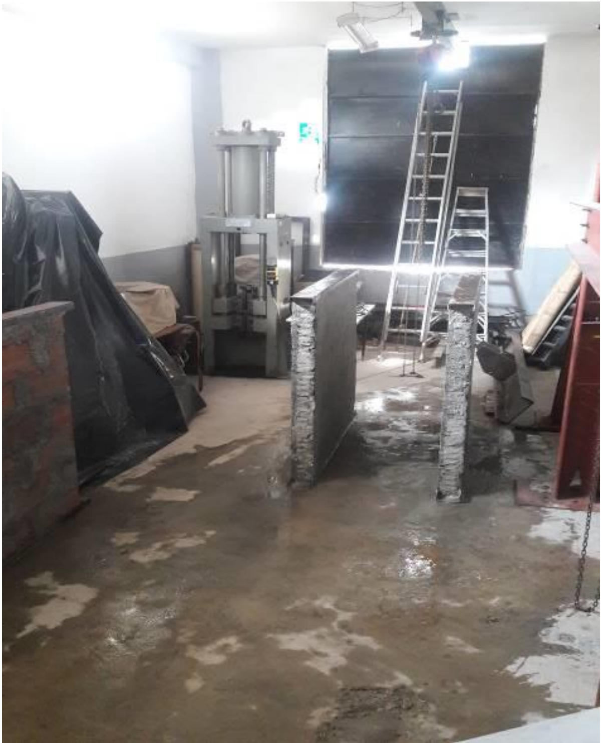
Ilustración 11: Curado del hormigón, laboratorio de Estructuras UCSG, Edward Badillo, 2020
