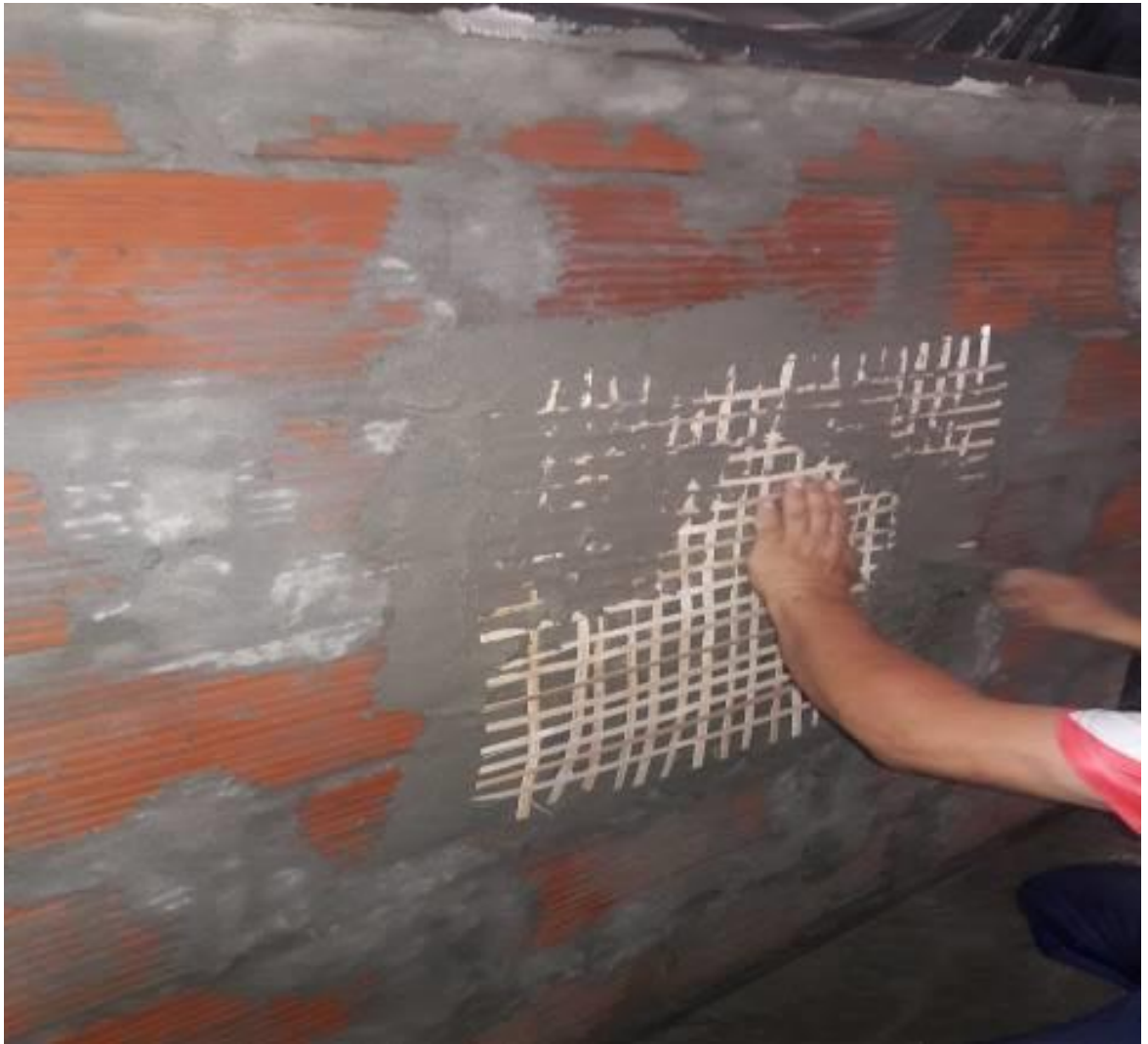
Ilustración 26: Panel reforzado con fibra de bambú, laboratorio de Estructuras UCSG, Edward Badillo, 2020
