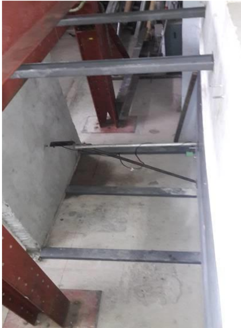
Ilustración 18: Puntales metálicos, lab. Estructuras UCSG, Edward Badillo, 2020
