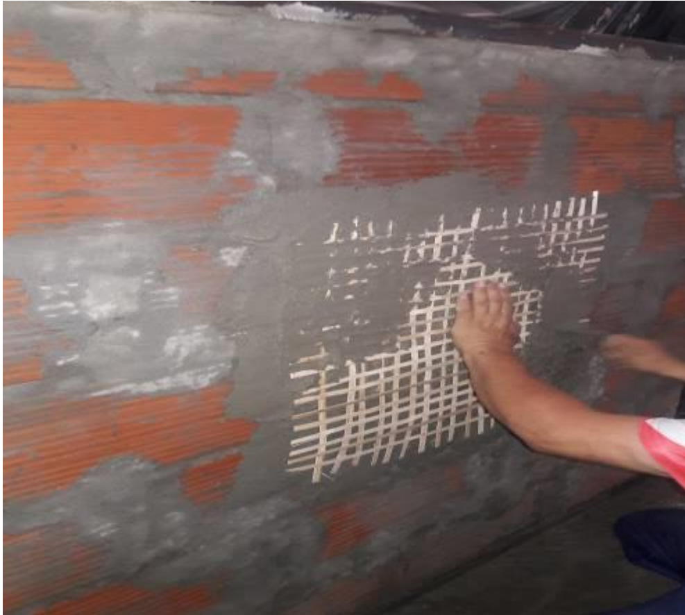
Ilustración 10: panel mampostería reforzado con fibra de bambú, lab. Estructuras UCSG, Edward Badillo.
