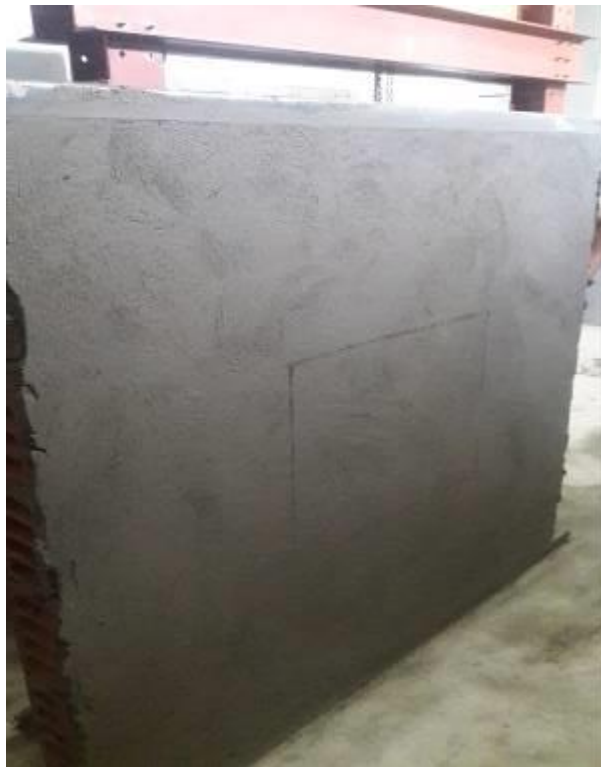
Ilustración 14: panel mampostería terminado, lab. Estructuras UCSG, Edward Badillo, 2020
