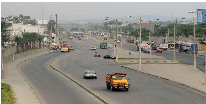
Figura 12. Tramo de la carretera E48.
