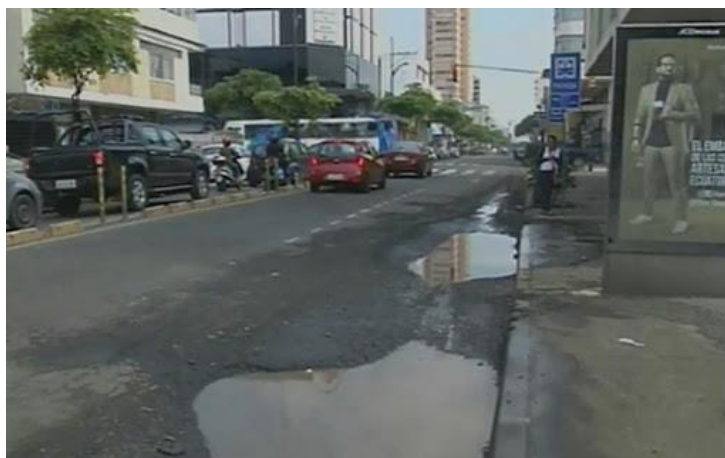
Figura 14. Aspecto de las calles durante el invierno. Fuente: (Teleamazonas, 2019).
