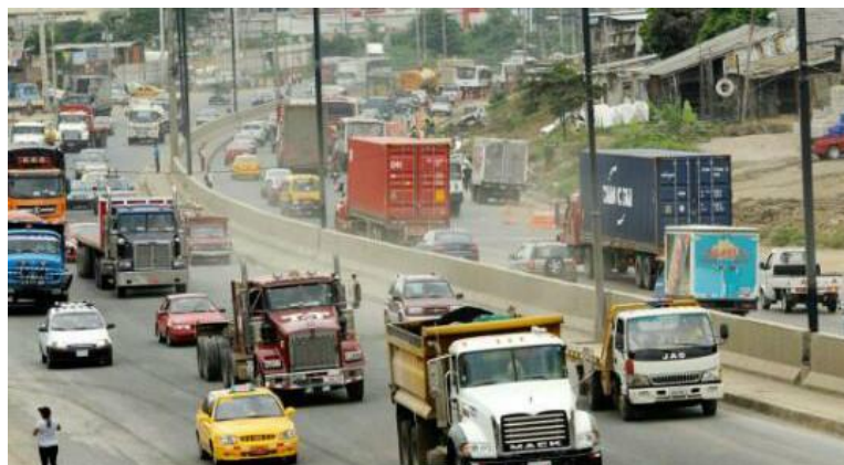
Figura 13. Capacidad de la vía Perimetral. Fuente: (FGE, 2016).
