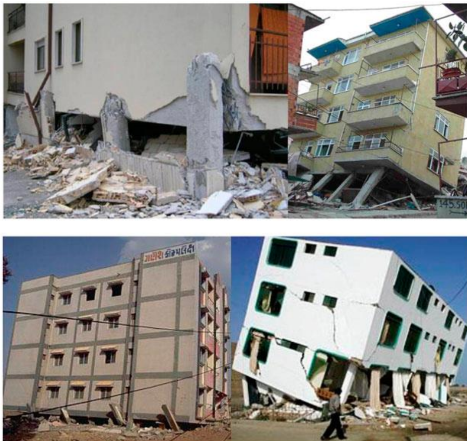
Ilustración 1: Ejemplos de fallas por piso débil producto de una distribución irregular de la mampostería en la altura. Obtenida de: Di Trapani et al. 2015
