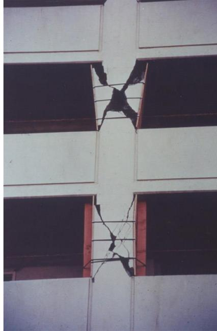
*Figura 1.4. Falla por corte en columna corta de hormigón armado. No existe un confinamiento apropiado ni una correcta separación con los elementos no estructurales. (Faison, Comartin, & Elwood, n.d.).*
