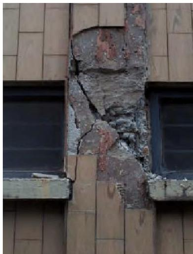
*Figura 1.6. Falla a cortante por efecto de columna corta generado por la pared de ladrillos de mampostería. (Reza, 2012).*
