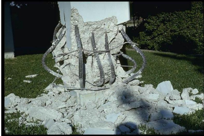
*Figura 1.5. Falla por carga axial elevada en una columna de hormigón armado. Se puede notar pérdida de recubrimiento y pandeo de varillas de acero longitudinal. Los estribos no fueron capaces de confinar satisfactoriamente el acero y el núcleo de hormigón. (Faison, Comartin, & Elwood, n.d.).*
