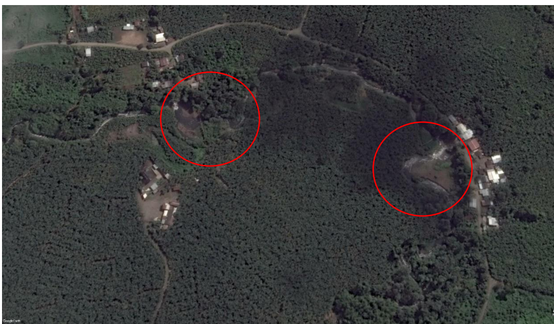
Imagen 67. Foto Ampliada Zona 2 (2014). Extraído desde Google Earth
