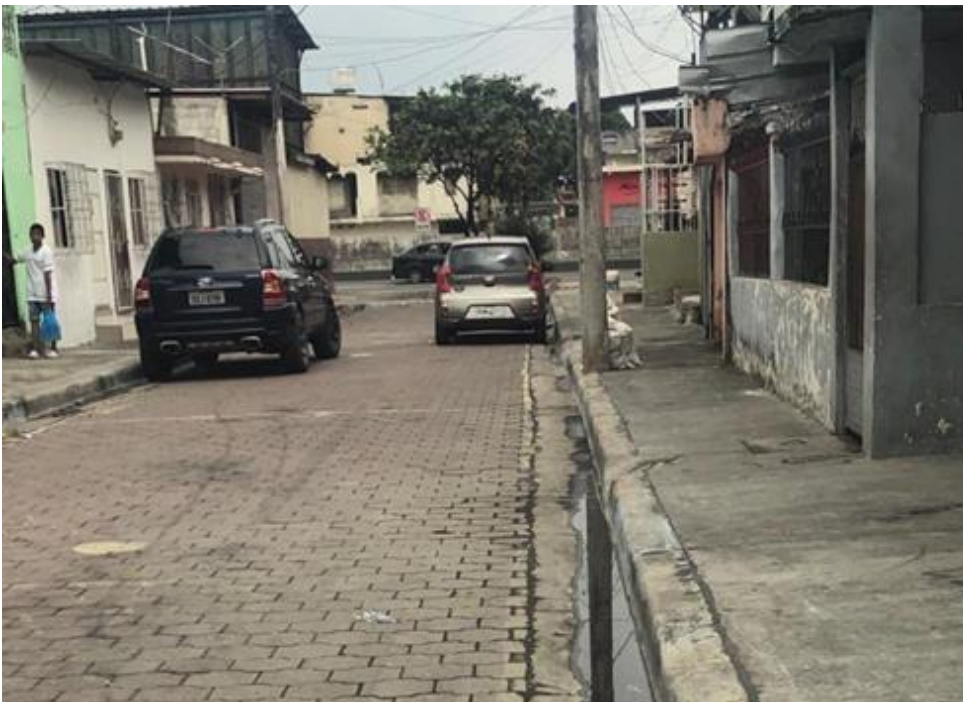
Figura 4 Calle peatonal de 9.50m adoquinada
