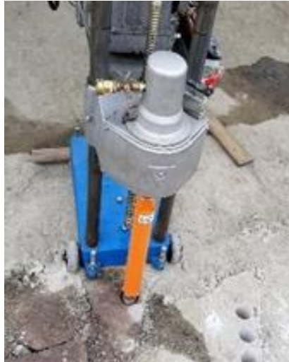
Figura 3.1. Barrenado de piedra
