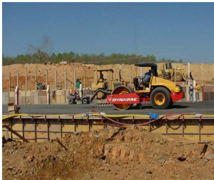
Figura 11. Preparación de un hormigón seco compactado con rodillo.
