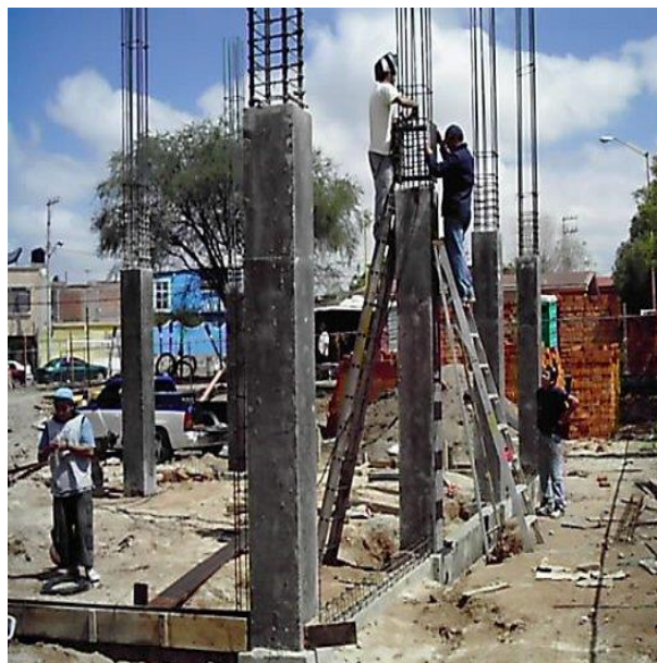
Figura 5. Foto de columna de hormigón armado.
