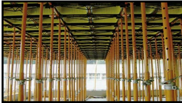
Figura 37. Foto de apuntalamientos.
