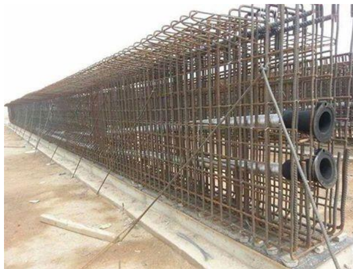
Figura 7. Armadura de un hormigón postesado con vainas para su posterior tensado.
