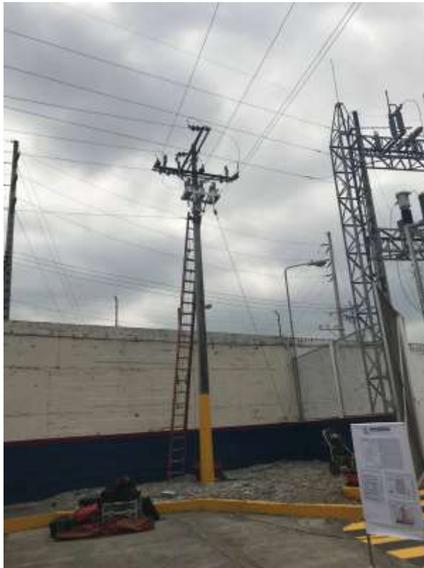
Anexo 7 Instalación de protección en banco de capacitores 3x100KVAR ramal inyección.
