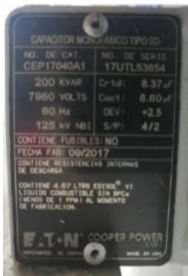
Ilustración 29: Datos de placa de banco de Capacitores 200KVAR Elaborado por Autor
