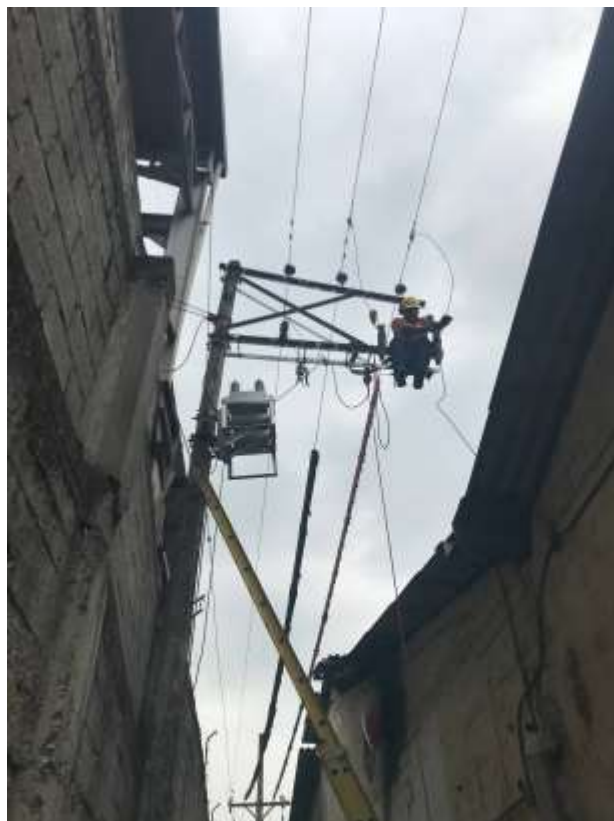
Anexo 7 Instalación de protección en banco de capacitores 3x100KVAR ramal inyección.
