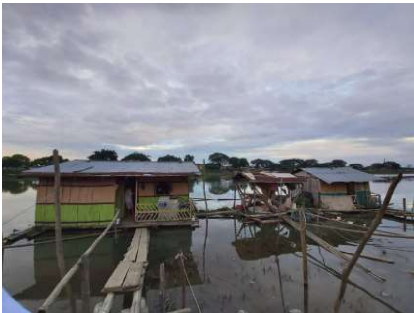
Anexo Q: Exterior de la vivienda.
