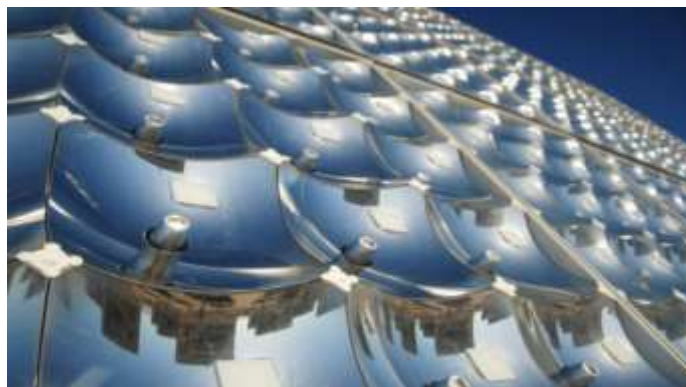
Figura 2.33 Fotovoltaica de concentración.
