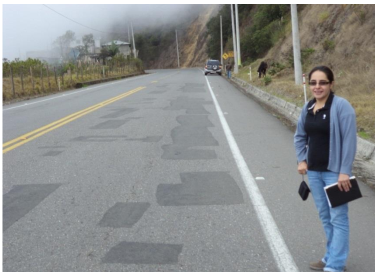
Figura 9. Vista general de la Vía Guasuntos – Chunchi
