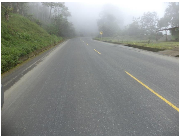
Figura 7. Vista general de la Vía Guaranda - Balzapamba
