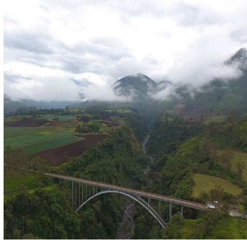
Figura C5. Puente Cornelio Davalos "Salsipuedes"
