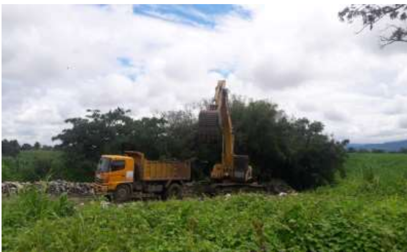
Figura A3. Mezcla de los desechos con arena y piedra en el relleno sanitario.
