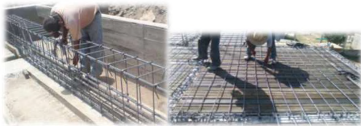
Figura 57: estructura de hierro Fuente: google (2019)
