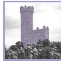
Torre del Vellón España
