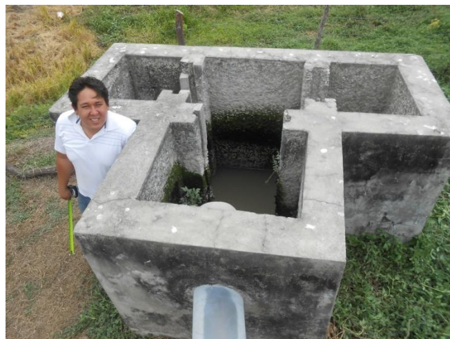
Foto No.15: Levantamiento de Precámara
