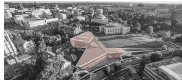
Ilustración 21: Perspectiva exterior Fuente: Plataforma Arquitectura, (2019)
