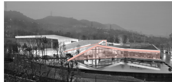
Ilustración 18: Perspectiva exterior Fuente: Plataforma Arquitectura, (2019)
