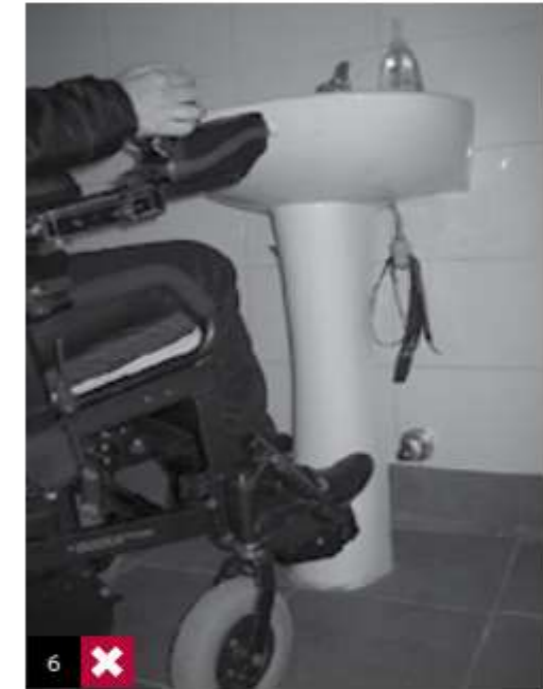
Foto 6: un lavamanos con pedestal no es accesible a una silla de ruedas. El pedestal impide el acercamiento de los apoyapies.
