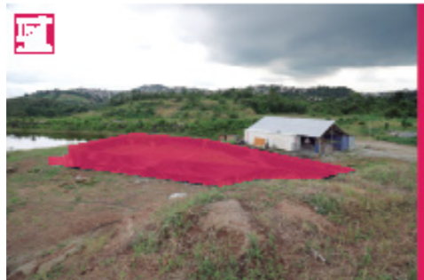
Imagen 23: Cimentación existente Fuente: Michelle Morán, 2019
