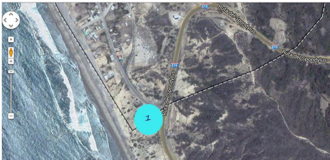
Gráfico 14: Vista Satelital y ubicación geográfica de la posible pista para deportes aéreos.
