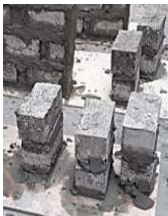
Ilustración 17. Construcción de 5 especímenes.
