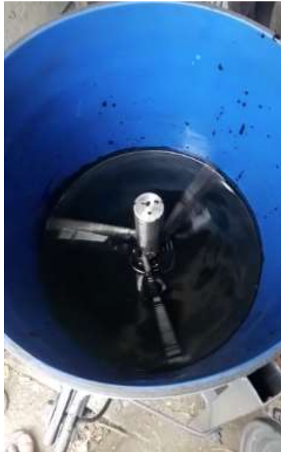
Ilustración 19 Lodo crudo ingresado en el biodigestor de alta tasa
