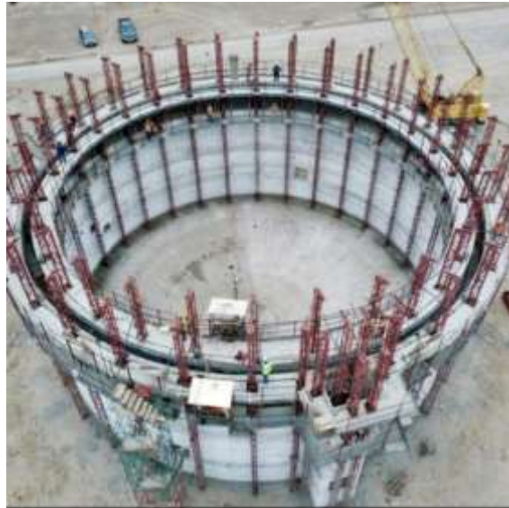
Ilustración 8 Construcción del digester anaerobio "Las Esclusas"
